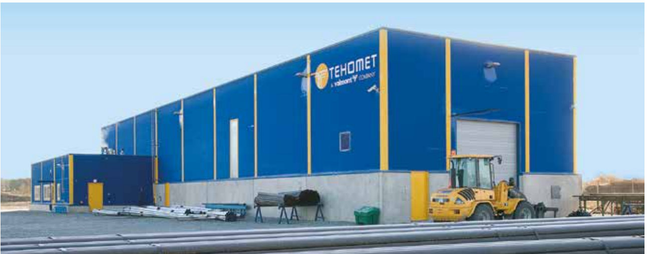
Site de production des mâts acier à Kiiu, Estonia.
